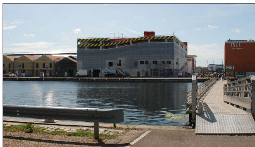
Réhabilitation de vieux bâtiments et construction hi-tech donnant une nouvelle image à ces quartiers de villes. (2009 - commune du Havre)
